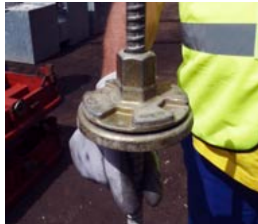
Sur un écrou standard, monobloc, chaque face assure une seule fonction : serrage ou blocage.
